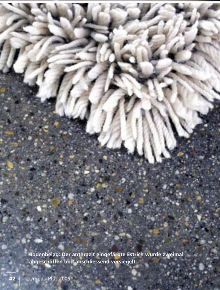
Bodenbelag: Der anthrazit eingefärbte Estrich wurde zweimal abgeschliffen und anschliessend versiegelt.
